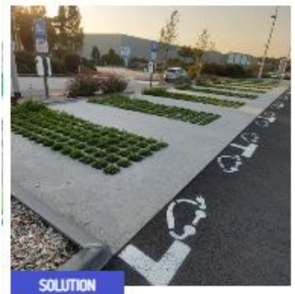
Installer des revêtements alvéolaires pour infiltrer les eaux pluviales dans les parkings
